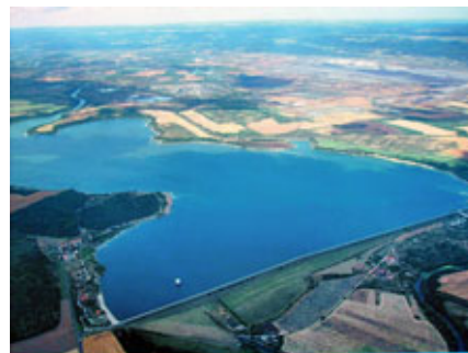
Pohled na nechanickou hráz
